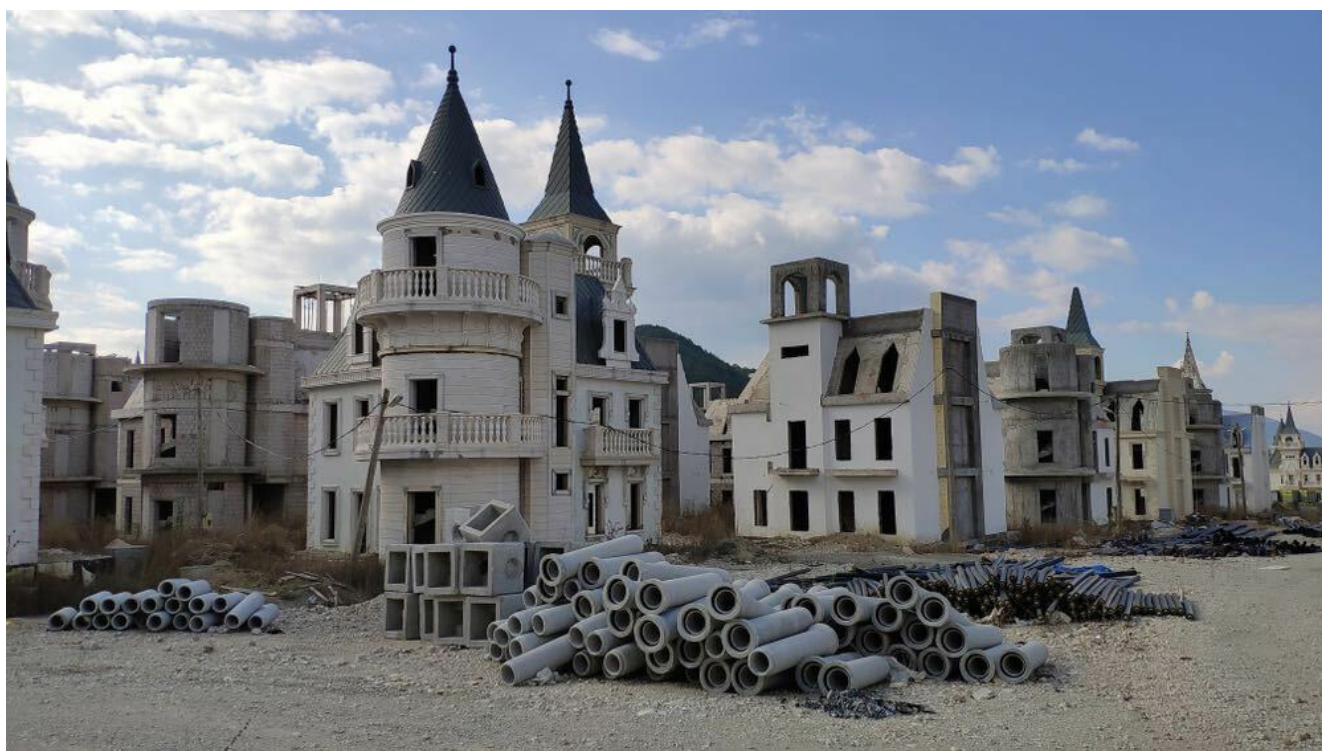
شکل ۱۰. چشم‌اندازی از ساختمان‌های نیمه‌کاره در برج الباباس
