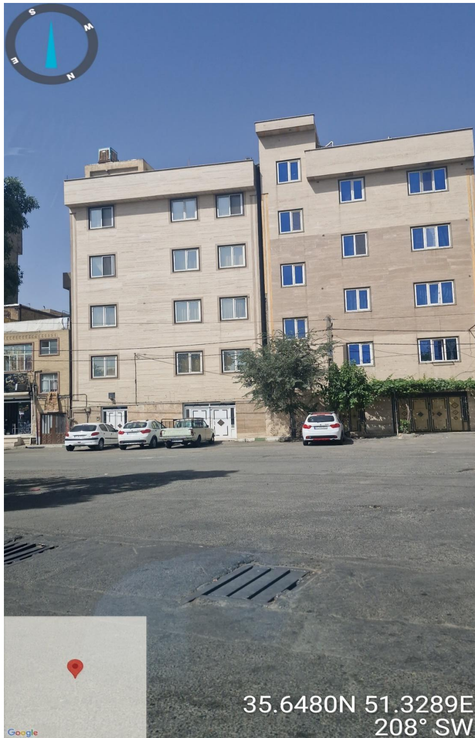
شکل ۱۹- تصاویری از معابر بازدید شده میدانی در منطقه ۱۸
