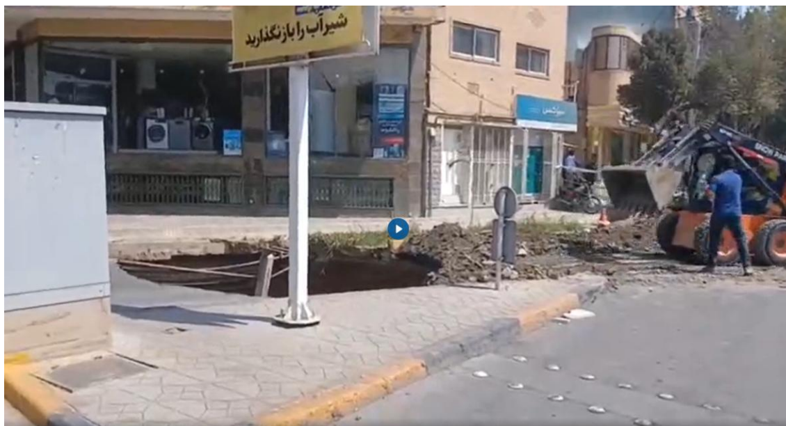
شکل ۵- حفره فرونشستی و عدم ترک خوردگی نمای آجری مجاور (تصویر برگرفته شده از سایت ایلنا)
